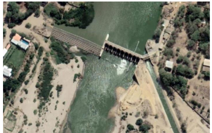
Fig. 1 Presa Los Ejidos vista en Google Earth.
